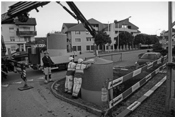
Im Herbst wurde beim Mehrzweckgebäude Neudorf ein Unterflurbehälter eingebaut
