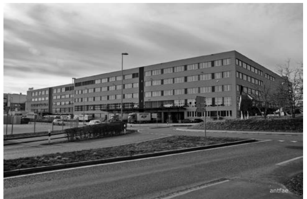
Das fertig erstellte Logistikzentrum der Dipl. Ing. Fust AG in Oberbüren
