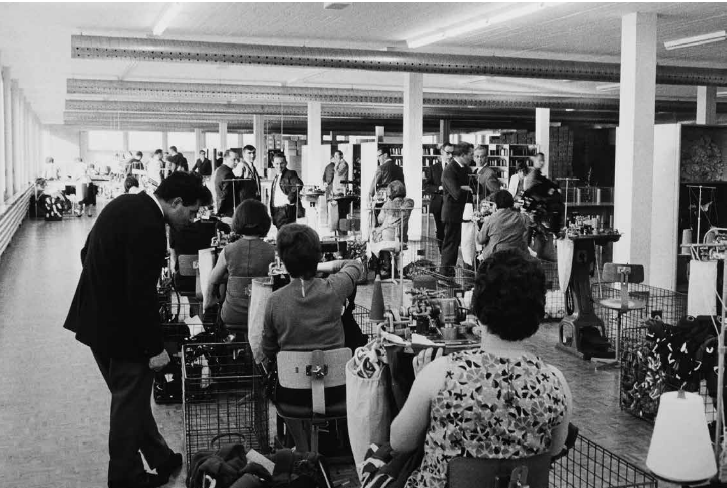
Einweihung der Fabrik Bodmer Niederwil, 1968
