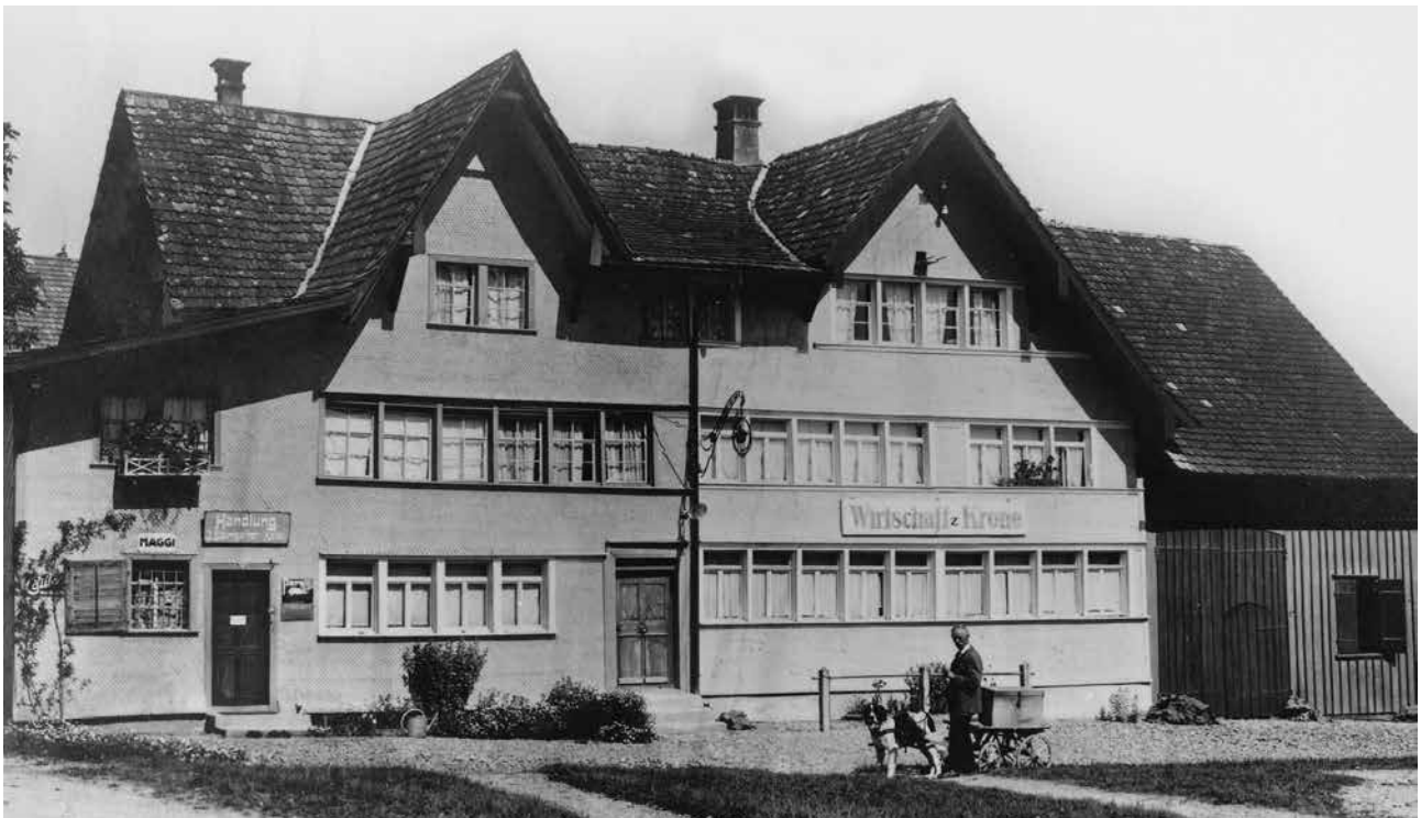
Die Krone in Niederwil musste 2016 einer Wohnüberbauung weichen.
