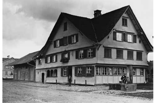
Das Restaurant Hirschen, die älteste Taverne Oberbürens, bestand schon im Mittelalter und ging in den 2010er Jahren ein.
