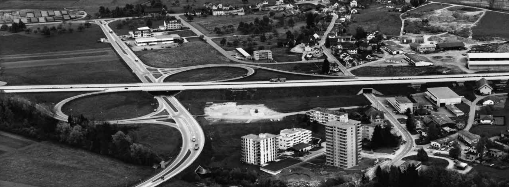
Flugaufnahme: Autobahn Ein- und Ausfahrt in Oberbüren mit Sicht auf das ganze Dorf Oberbüren, 1974
